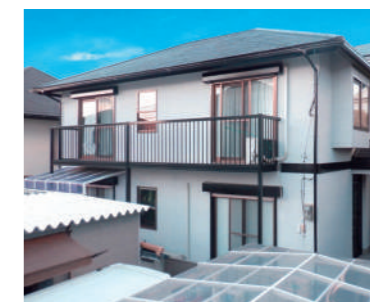
施工から5年経過後の様子
