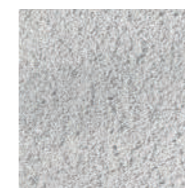
施工直後のUP
