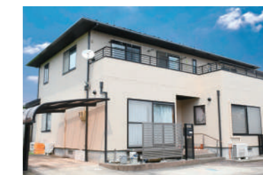
色:メリノ 施工時期:2017年12月
