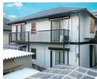
施工直後の様子
